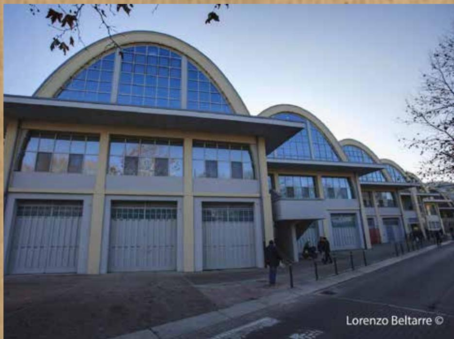
Nel 2015 è stato restaurato mantenendone la stessa leggerezza strutturale e leggibilità degli elementi costruttivi. Sono così stati progettati dall'Ingegnere Alberto Tricarico grandi arconi metallici reticolari in affiancamento all'attuale struttura in laterizio che "aiutano" la struttura esistente, consentendole di rispettare i parametri legislativi relativi ai sovraccarichi accidentali.
